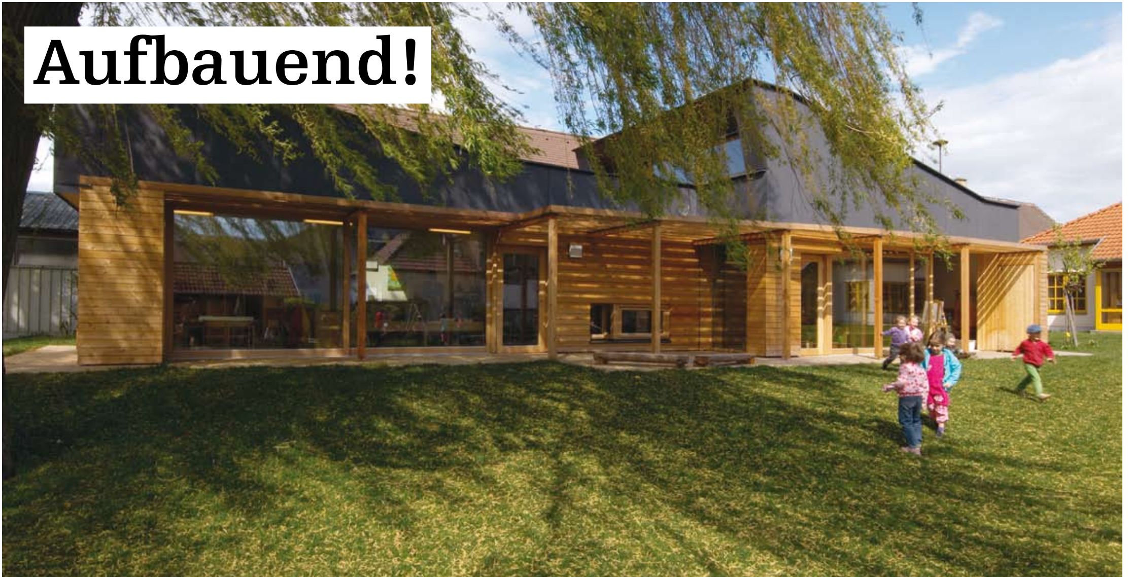
Kindergarten Rohrendorf, GABU Heindl Architektur. Foto: Lisa Rastl
